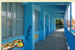
Fotos de la escuela con los muros pintados.
